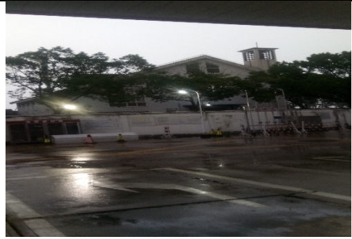
东侧西门泵站
