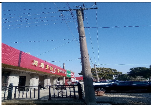
北侧民建及架空电力线
