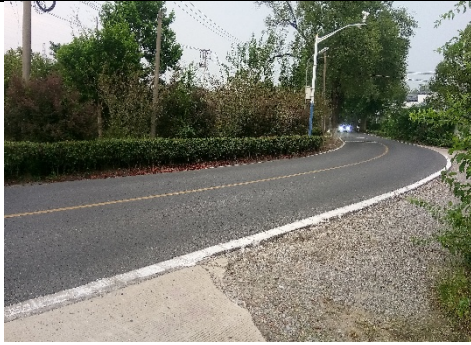
北侧宏海公路
