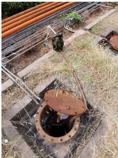
溶剂储罐检测孔排水
