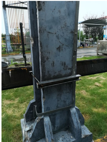
溶剂管线进车间前接地
