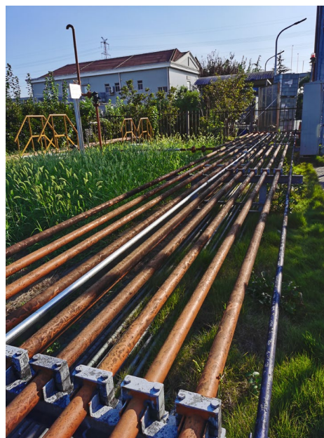
溶剂地下储罐增加充氮保护
