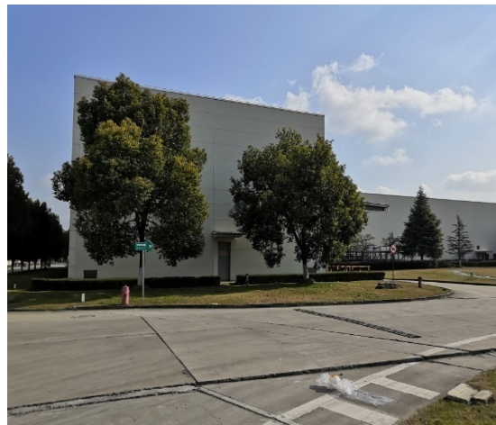
图4 拟建甲类车间周边情况图（东面-危险品仓库）
