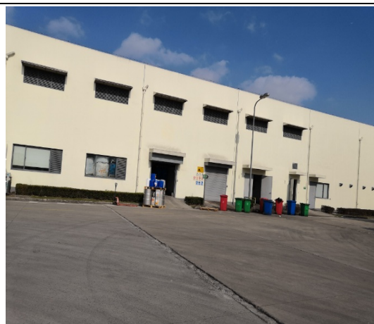
图2 拟建甲类车间周边情况图（北面-污水处理站、固废收集站）
