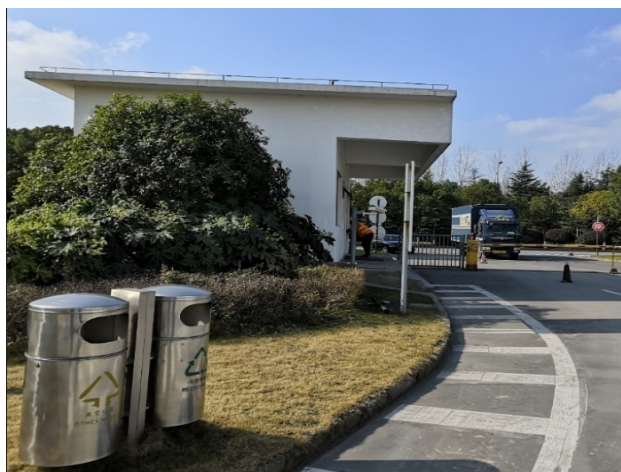
图3 拟建甲类车间周边情况图（北面-现西门门卫房）
