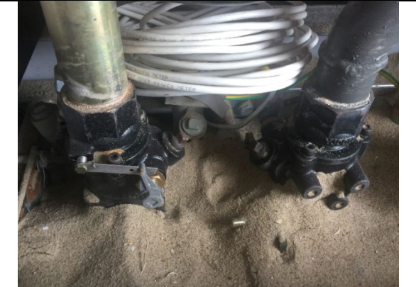
加油机防撞剪切阀
