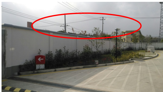
南侧、西侧：架空电力线
