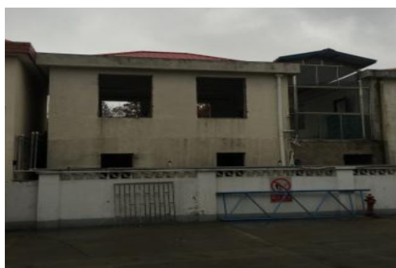
图<4>北侧-海光公司办公楼
