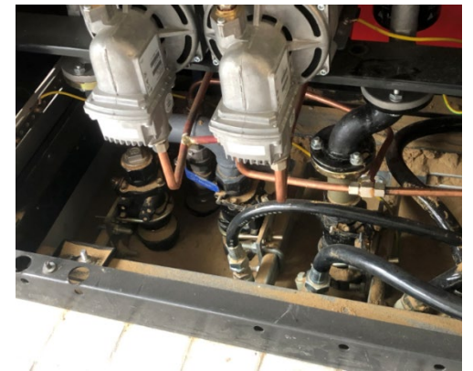
加油机防撞剪切阀
